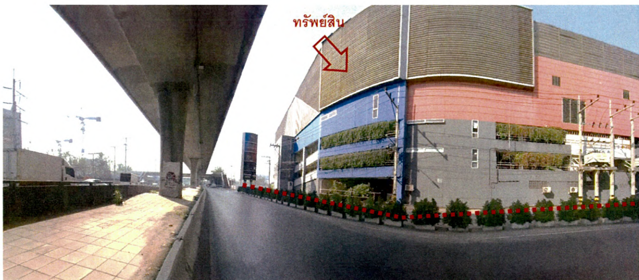
สภาพบริเวณด้านหลังที่ตั้งทรัพย์สิน /ติดทางหลวงต่างระดับรังสิต (จุดถ่ายภาพที่ 6)
