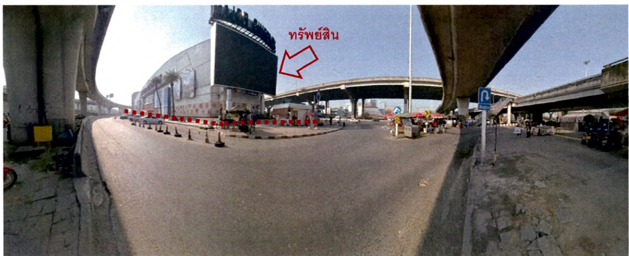
สภาพบริเวณด้านหลังที่ตั้งทรัพย์สิน /ติดทางหลวงต่างระดับรังสิต (จุดถ่ายภาพที่ 12)
