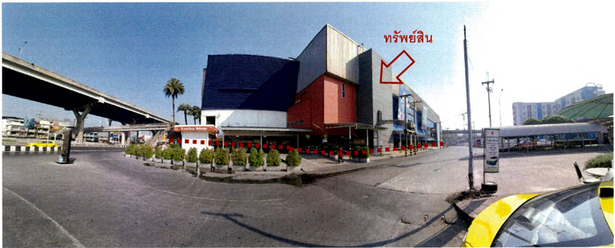
สภาพบริเวณด้านข้างที่ตั้งทรัพย์สิน /ติดซอยโครงการฯ (จุดถ่ายภาพที่ 2)
