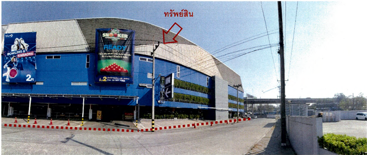
สภาพบริเวณด้านข้างที่ตั้งทรัพย์สิน /ติดซอยโครงการฯ (จุดถ่ายภาพที่ 4)
