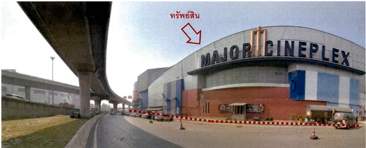
สภาพบริเวณด้านหลังที่ตั้งทรัพย์สิน /ติดทางหลวงต่างระดับรังสิต (จุดถ่ายภาพที่ 10)
