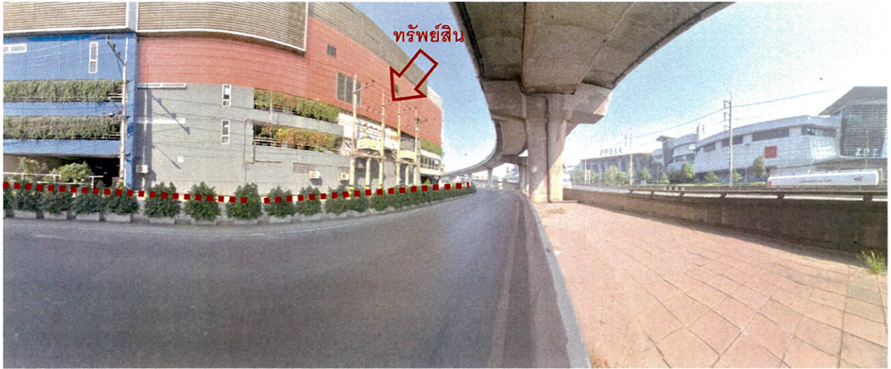
สภาพบริเวณด้านหลังที่ตั้งทรัพย์สิน /ติดทางหลวงต่างระดับรังสิต (จุดถ่ายภาพที่ 7)
