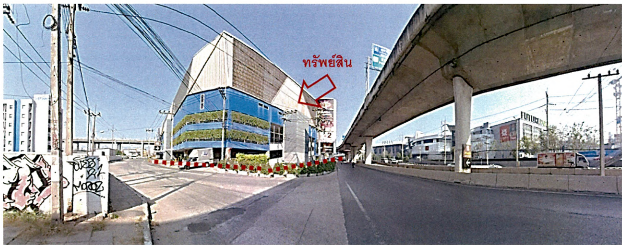
สภาพบริเวณด้านหลังที่ตั้งทรัพย์สิน /ติดทางหลวงต่างระดับรังสิต (จุดถ่ายภาพที่ 5)
