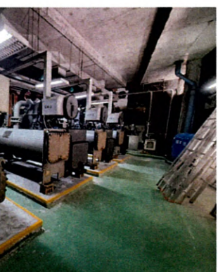
สภาพระบบทำความเย็นอาคาร - เครื่องซิลเลอร์ ตู้ควบคุมไฟฟ้า บั๊มน้ำ กรองน้ำ และ หอระบายความร้อน
