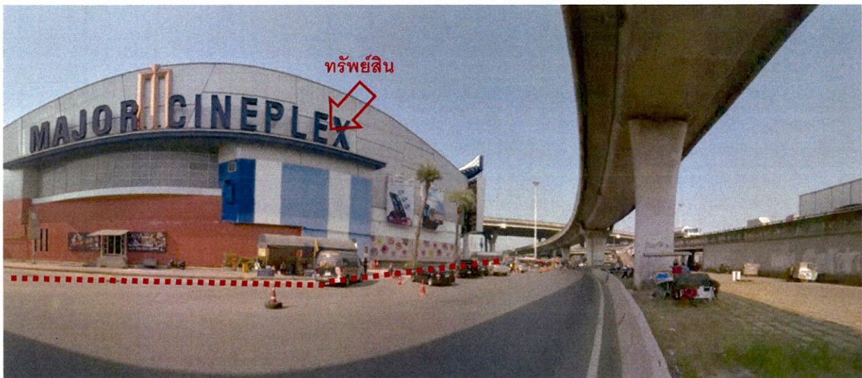
สภาพบริเวณด้านหลังที่ตั้งทรัพย์สิน /ติดทางหลวงต่างระดับรังสิต (จุดถ่ายภาพที่ 11)
