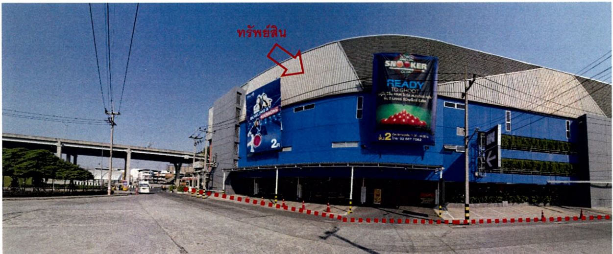
สภาพบริเวณด้านข้างที่ตั้งทรัพย์สิน /ติดซอยโครงการฯ (จุดถ่ายภาพที่ 3)
