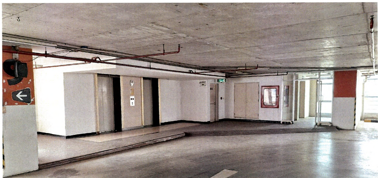
สภาพภายในอาคารชั้นที่ 1 - 11 โถงหน้าลิฟต์โดยสารและขนของ และลานจอดรถ
