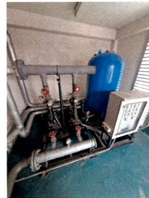
สภาพระบบอาคาร - เครื่องปั๊มแรงดันน้ำ ตู้สลายดับเพลิง สปริงเกอร์ ประตูและบันไดหนีไฟ
