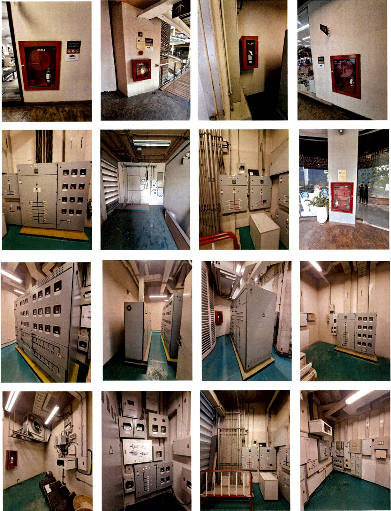
สภาพระบบอาคาร - ควบคุมไฟฟ้า และดับเพลิง
